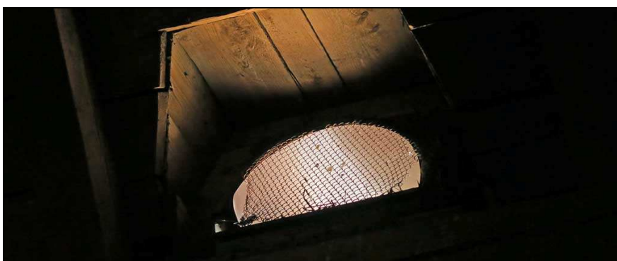
Uzavření vykřívů mřížkami proti vniknutí holubů.
